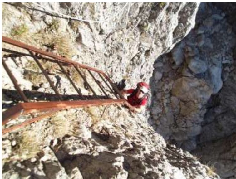
Scaletta canalino (vista dall'alto)
